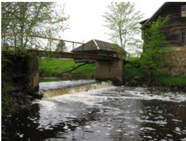
Foto 6. Viisireiu paisu paisutuskõrgus on 0,75 m. Paisul puudub kalapääs. Tõkestusrajatiste inventariseerimise (2013) käigus on hinnatud läbipääsu mõju siirdekaladele väheoluliseks, kuid läbipääsu mõju veekogu kalastiku seisundile on hinnatud oluliseks.
