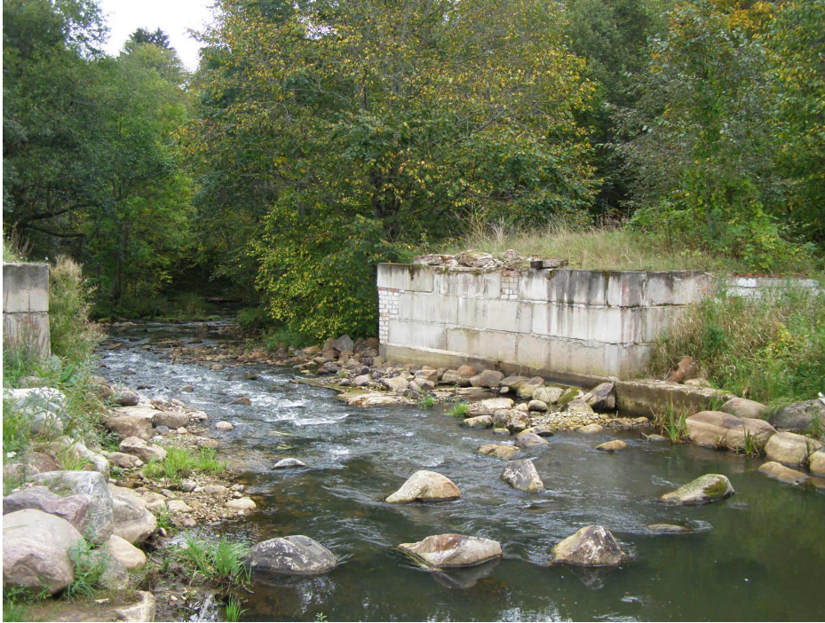
Foto 3. Oro veskikoht on kujundatud kiviseks kärestikuks (20.09.2012).
