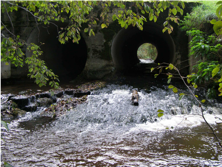
Foto 4. Kiviojal Vana-Vastseliina - Käänu tee kaksiktruup – selle all olev astang on madala veega kaladele rändetõkkeks (20.09.2012).
