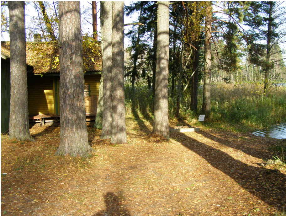
2. Järvekalda kinnistu, millel lagunenu seisukorras hoone. Paremalt paistab supluskoht. Puumajal maas on hoiuala tähis. Tähise metallpostile on taas „leitud muu rakendus“ (18.10.2012).
